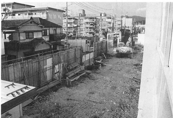
附属病院西側工事現場
