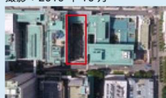
臨床講堂棟解体
