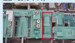
臨床講堂棟解体開始
