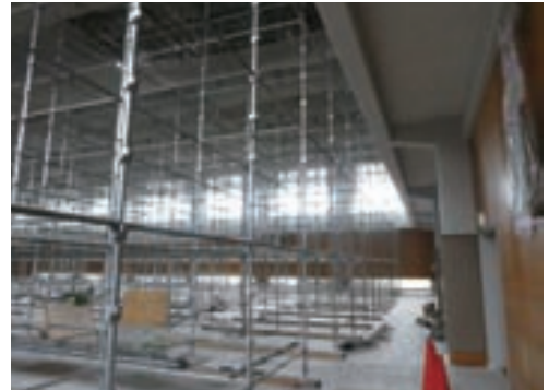
体育館の工事風景
