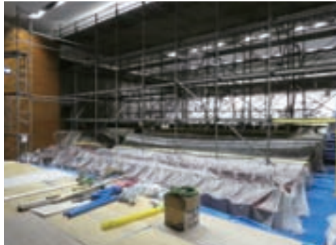
D棟講堂の工事風景
